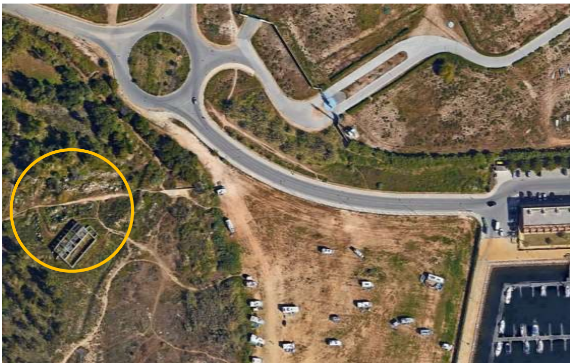
Figura 6.8.1 - Exemplo de área a sujeitar a demolição e limpeza de deposição ilegal de resíduos (assinalada com uma circunferência amarela)
