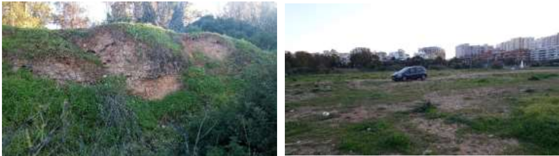
Figura 5.3.4 - Zona central e ocidental da área de estudo: (a) Blocos de betão armado (RCD); (b) Zonas de solo natural (areias de praia); (c) Depósitos de RCD; (d) Parque de estacionamento
